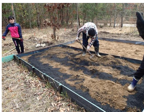
敷設マサ土へ木炭を混合して試験区を設定
